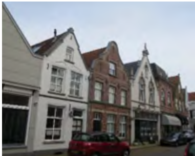
Topgevels met zadeldakken (Marktstraat)
