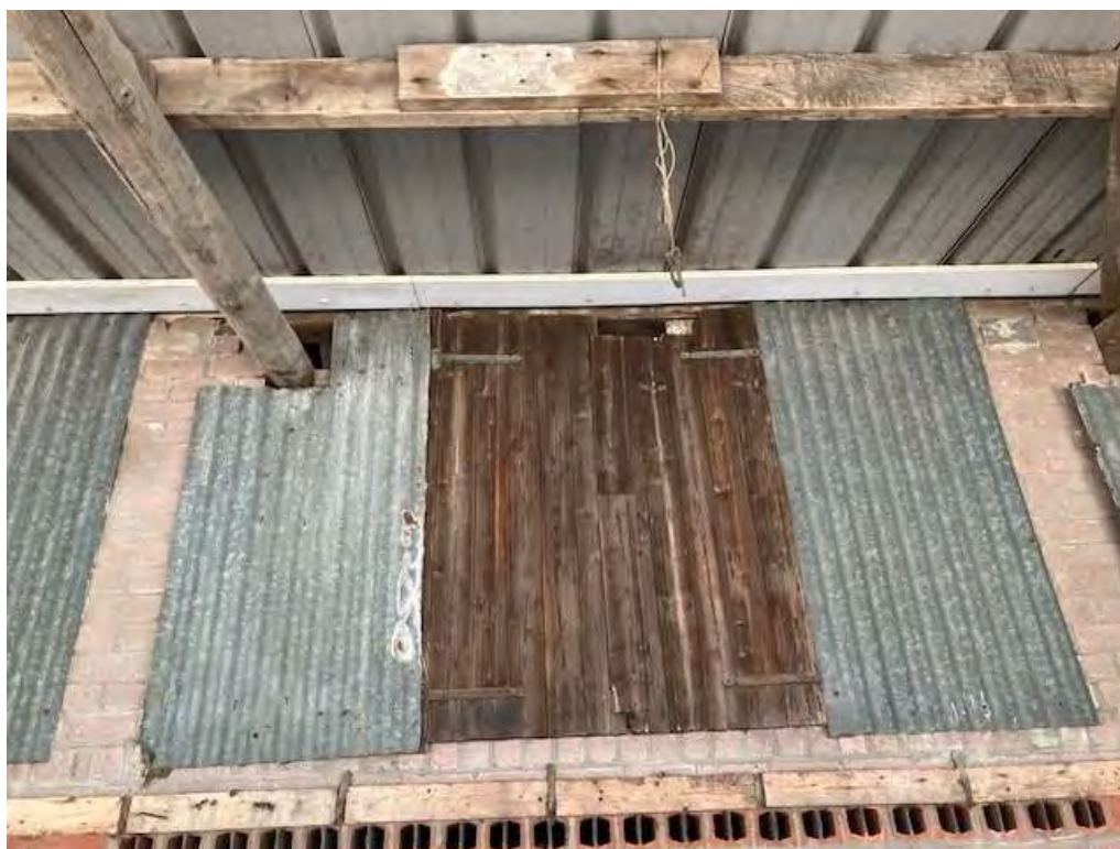
• Afbeelding 10: onderzijde overkapping, oorspronkelijke buitengevel
