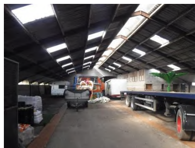
Foto 2 binnenkant dak opstal 1
