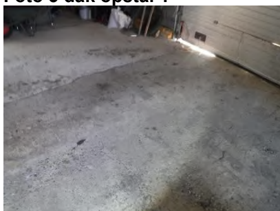
Foto 5 betonnen vloer in opstal 3
