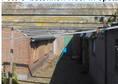
Foto 7 tussenruimte/gangpad van opstal 3
