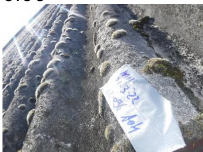
Foto 1 M01 dak opstal 1
