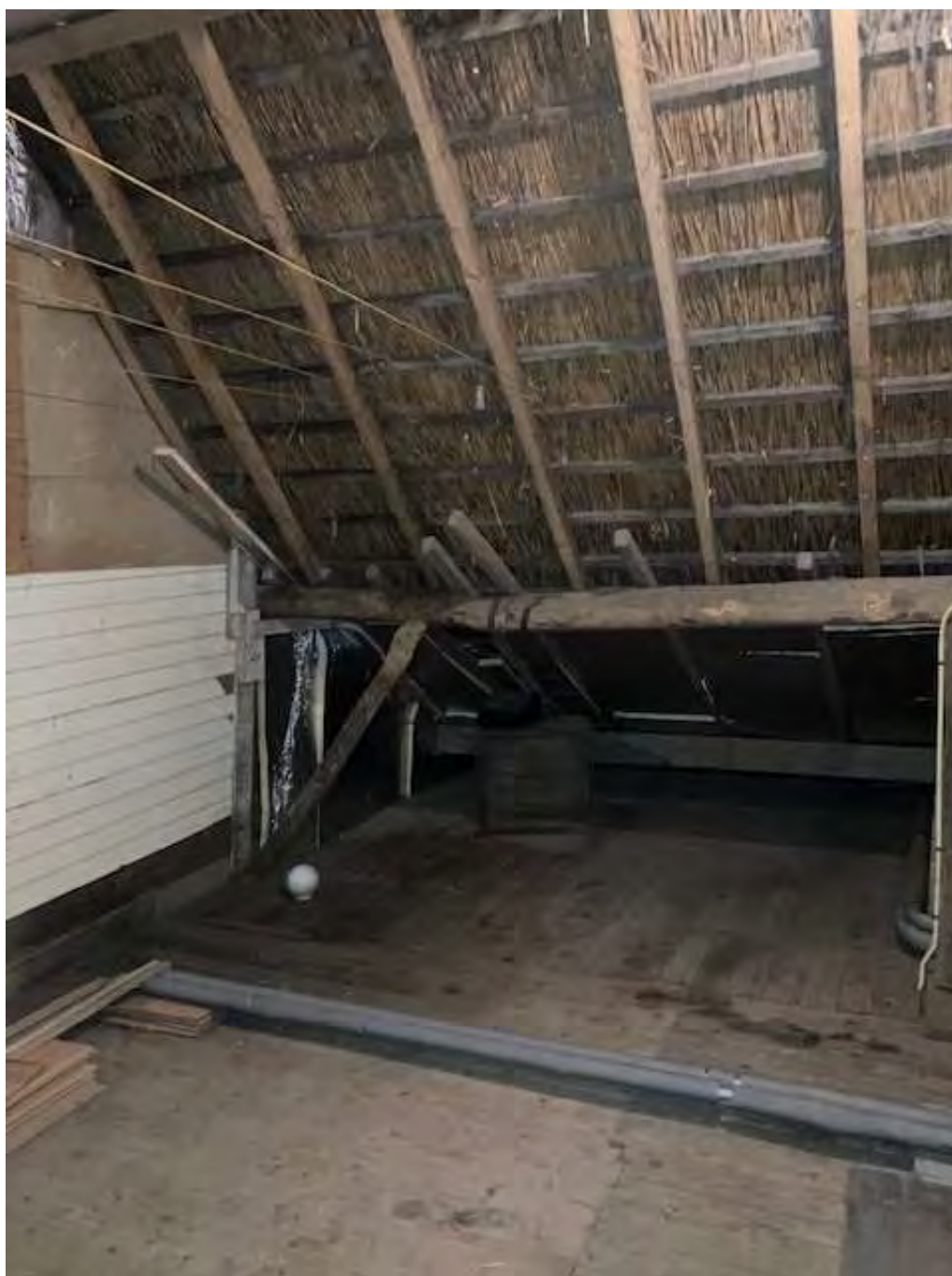
• Afbeelding 26: onderzijde dak boerderijwoning
