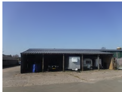
Foto 14 opstal 2 – overdacht – metalen dakplaten
