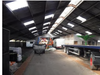
Foto 2 binnenkant dak opstal 1
