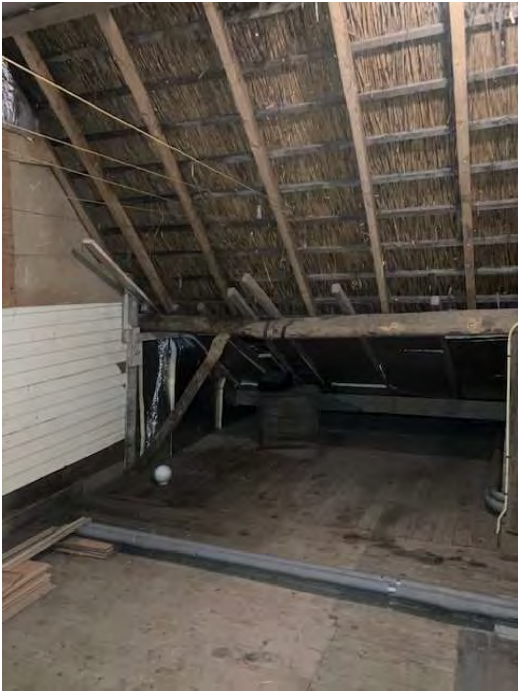
• Afbeelding 26: onderzijde dak boerderijwoning
