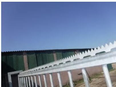
Foto 15 metalen en houten gevelplaten opstal 2
