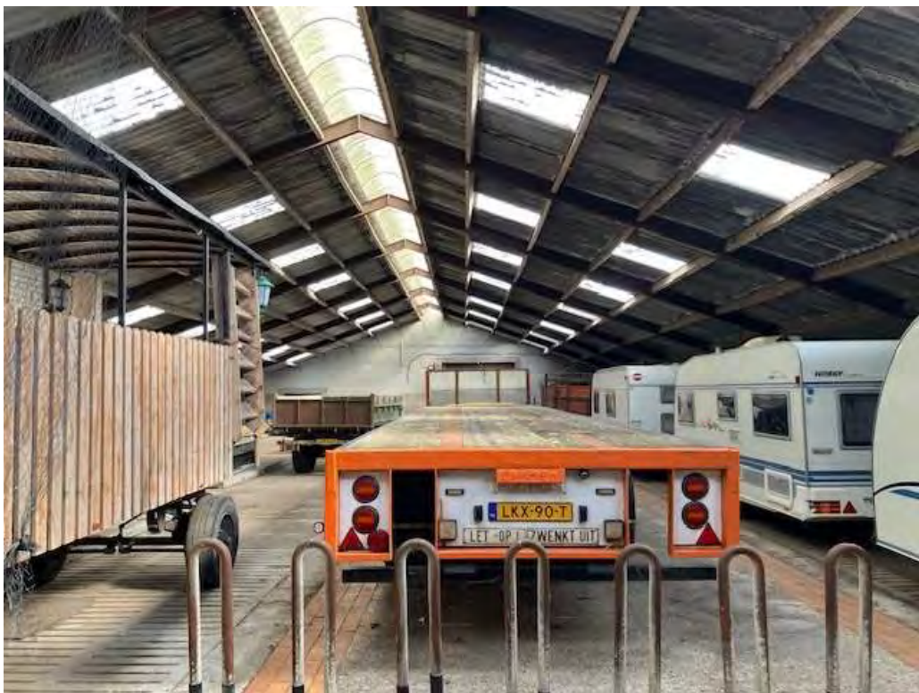
• Afbeelding 14: binnenzijde voormalige ligboxenstal, dak is van ongeïsoleerde golfplaten
