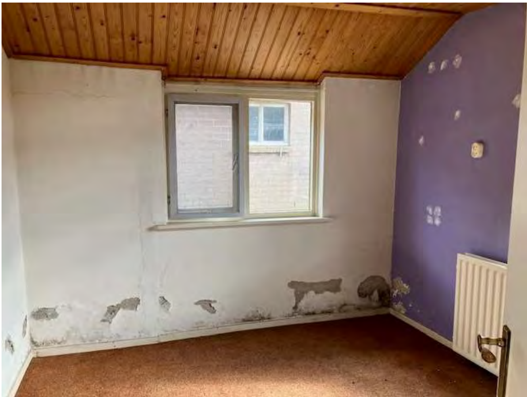
• Afbeelding 19: slaapkamer, duidelijk sporen van vocht in de buitengevel
