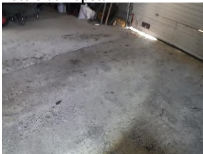
Foto 5 betonnen vloer in opstal 3
