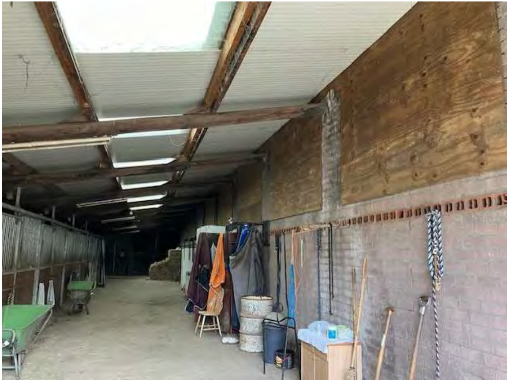
• Afbeelding 5: binnenzijde paardenstal, netjes opgeruimd
