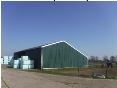
Foto 11 opstal 4 – onverdacht – asbestvrije golfplaten
