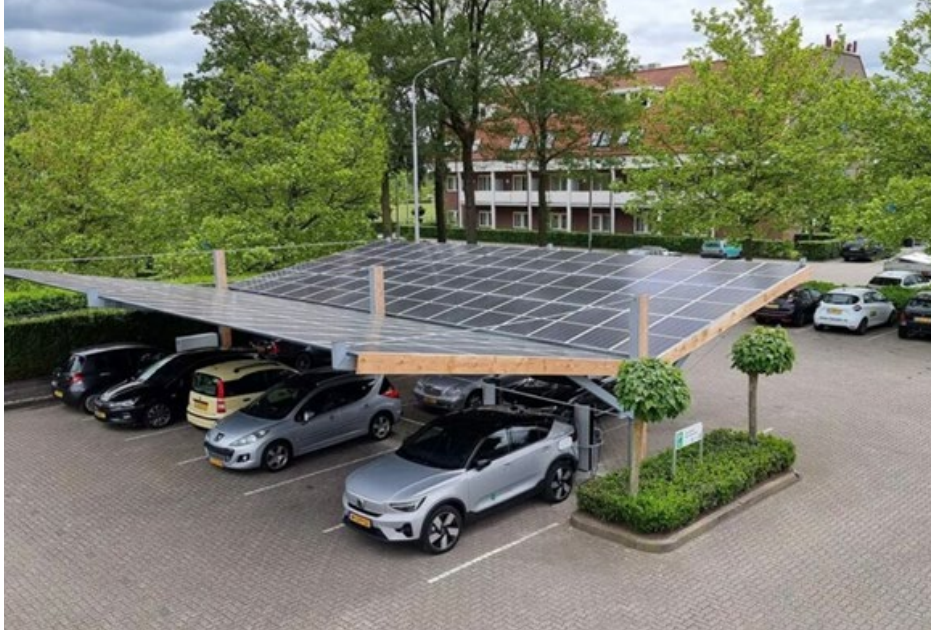
Combineren van parkeren en opwek zonne-energie
