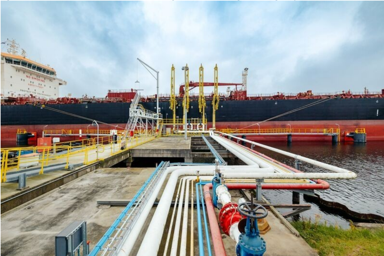
Figuur 7 Amsterdam als voorbeeld voor de energietransitie: aanleg van energie-infrastructuur
