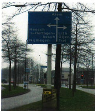
Fig. 7 Plaatdeel op mast Zonder verlichting
