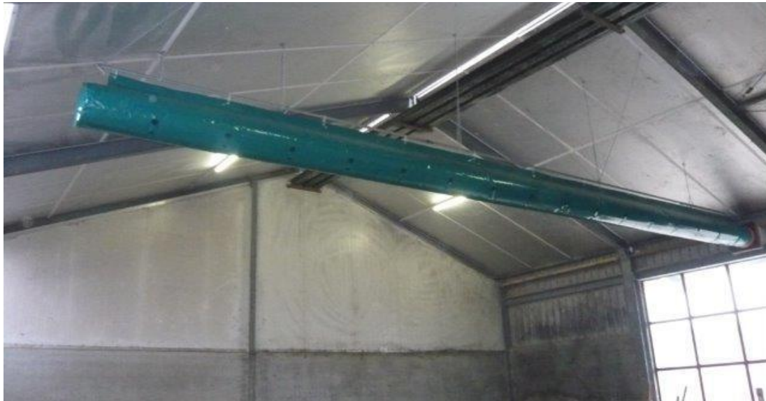
Voorbeeld van een opgehangen PVC-doek buis. Let ook op het ophangstelsel.
